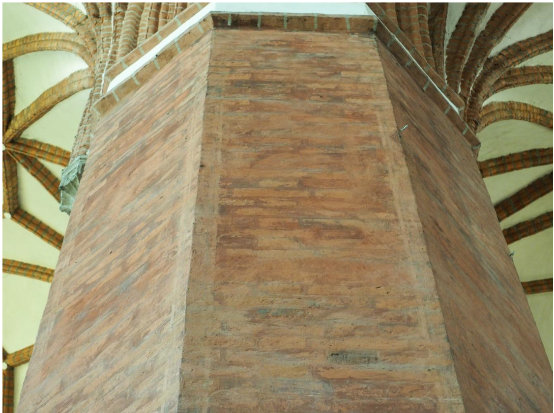
35. Bazylika Mniejsza pw. Św. Katarzyny Aleksandryjskiej w Braniewie, wnętrze, strona południowa, trzeci filar od zachodu. Widoczne ślady polichromii – lancety.
