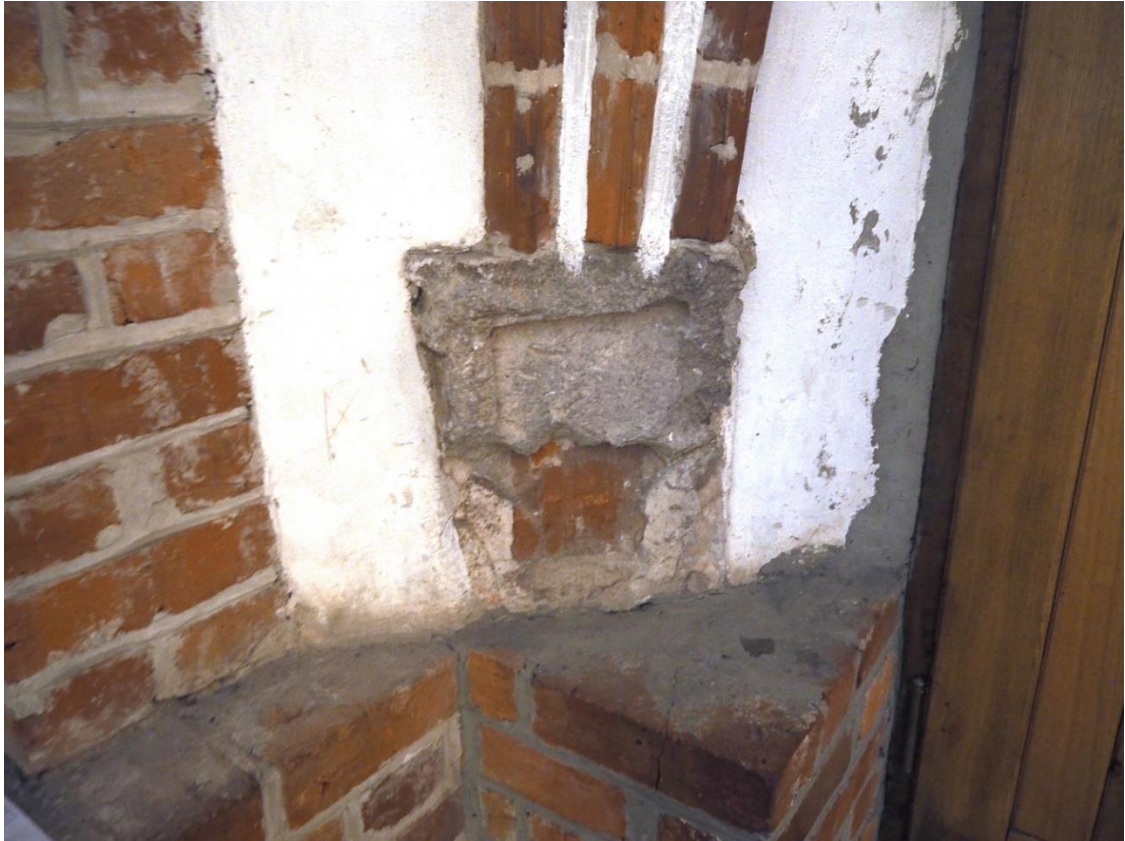
68. Bazylika Mniejsza pw. Św. Katarzyny Aleksandryjskiej w Braniewie, wewnątrz, południowo zachodni narożnik kruchty zachodniej. Widoczny relikw konsoli służek.
