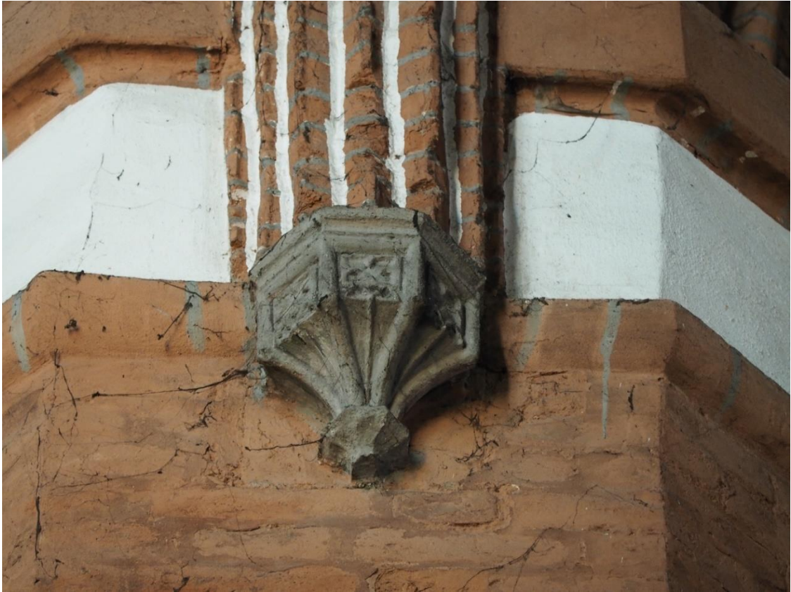
58. Bazylika Mniejsza pw. Św. Katarzyny Aleksandryjskiej w Braniewie, wnętrze, strona północna. Widoczna maswerkowa konsola słupek.
