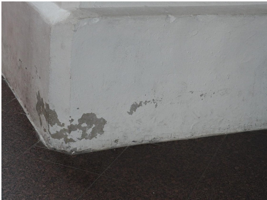
27. Bazylika Mniejsza pw. Św. Katarzyny Aleksandryjskiej w Braniewie, wewnątrz, strona południowa, cokół pierwszego filaru od zachodu.
