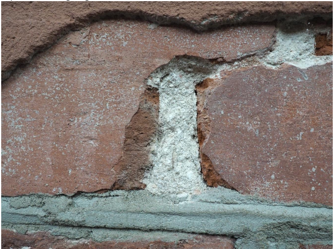
38. Bazylika Mniejsza pw. Św. Katarzyny Aleksandryjskiej w Braniewie, wewnątrz, strona południowa, czwarty filar od zachodu. Widoczna odkrywka; nieestetyczne spoinowanie zaprawą cementową; uzupełnienie lica ceglanego.
