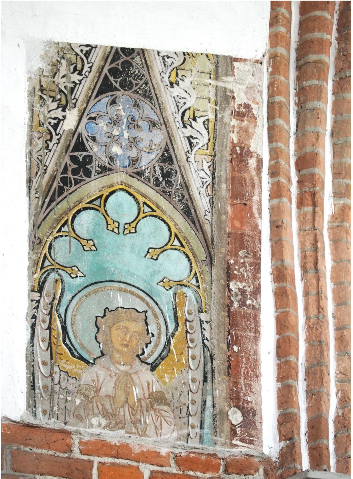
72. Bazylika Mniejsza pw. Św. Katarzyny Aleksandryjskiej w Braniewie, wewnątrz, strona północna. Widoczny zachowany fragment dekoracji malarskiej podniebia łuku tęczowego.
