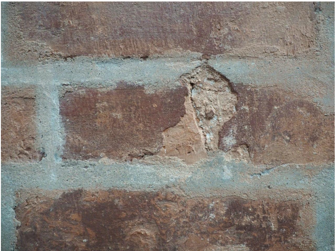
49. Bazylika Mniejsza pw. Św. Katarzyny Aleksandryjskiej w Braniewie, wewnątrz, strona północna, trzeci filar od zachodu - detal. Widoczne relikty warstwy barwnej; spoinowanie zaprawą cementową.
