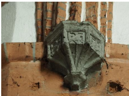
Przykład konsoli maswerkowej wykonanej z gipsu jastrychowego, pomalowanej szarą farbą. Obok na gzymsie i spływie sklepiennym widoczne spoiny pomalowane taką samą farbą.
