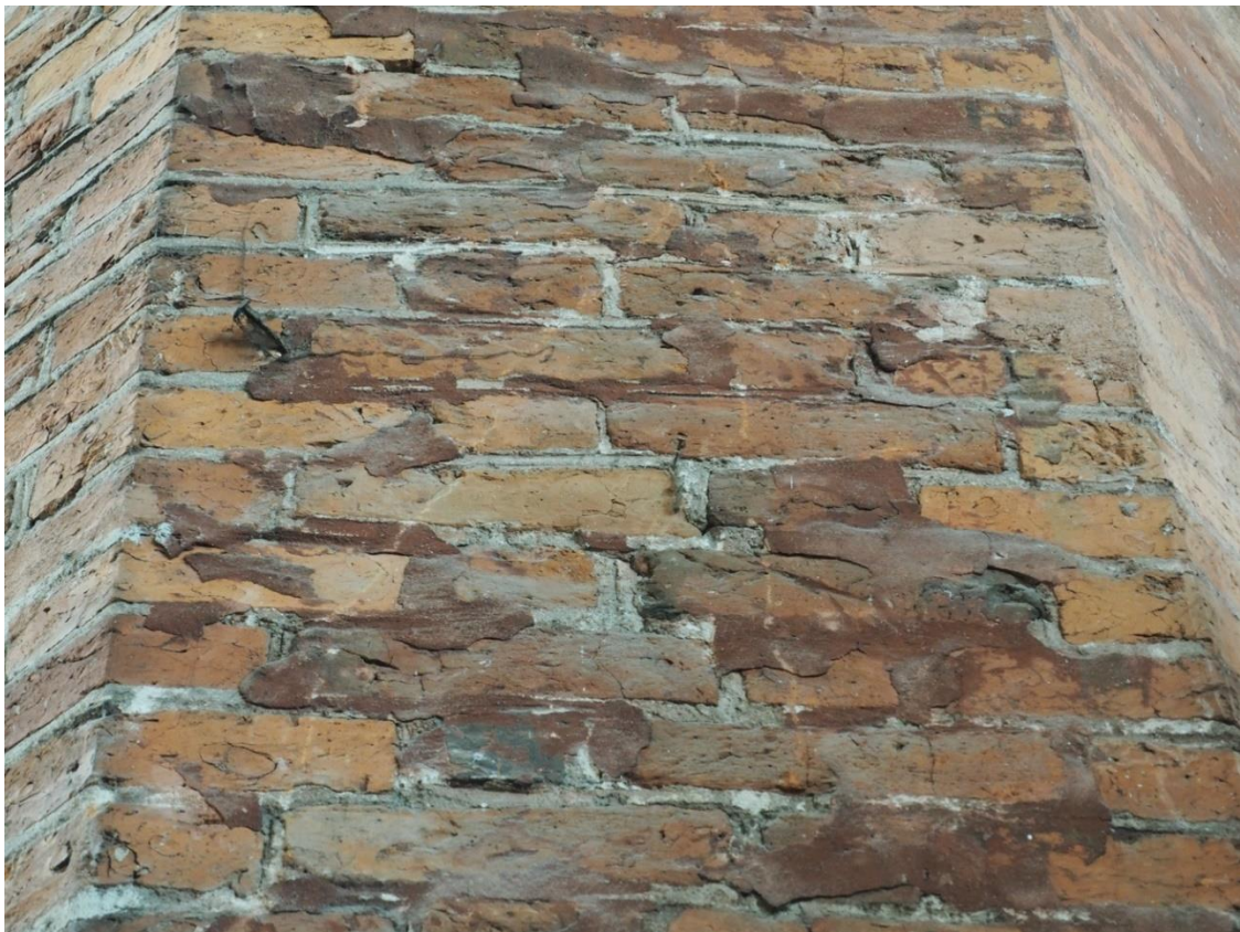
51. Bazylika Mniejsza pw. Św. Katarzyny Aleksandryjskiej w Braniewie, wewnątrz, strona północna, czwarty filar od zachodu - detal. Widoczne relikty warstwy barwnej.
