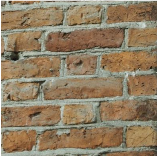
Lico muru z zachowaną spoinach średniowieczną zaprawą z charakterystycznym podcięciem.
