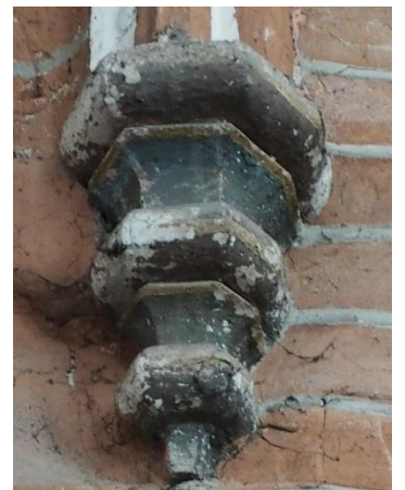
Zachowana polichromia na konsoli na ścianie północnej prezbiterium
