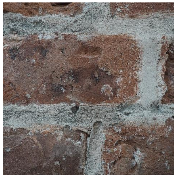
Zbliżenie powierzchni ściany – widoczne uzupełnienia
