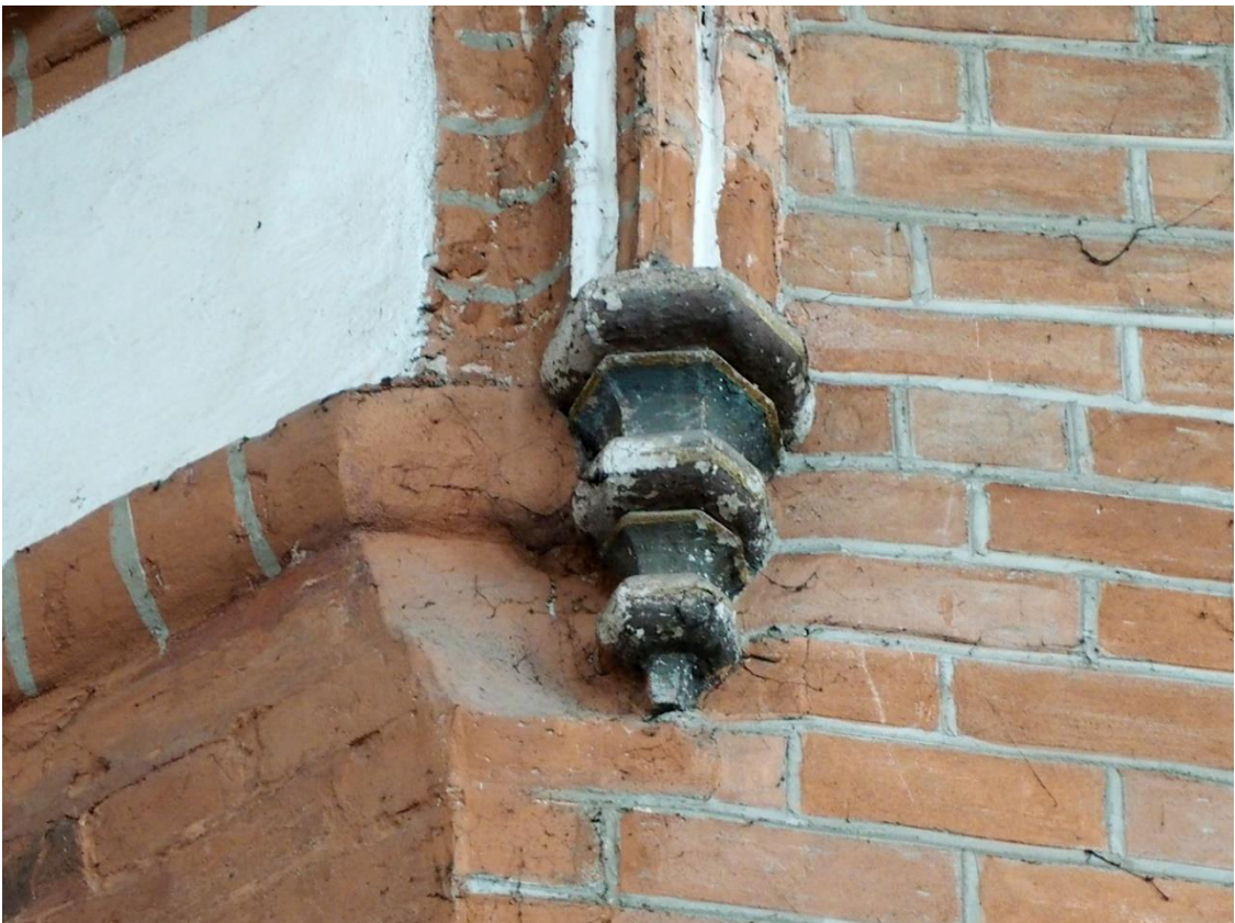
61. Bazylika Mniejsza pw. Św. Katarzyny Aleksandryjskiej w Braniewie, wewnątrz, prezbiterium, strona północna. Widoczna konsola słupek; relikty warstw barwnych.
