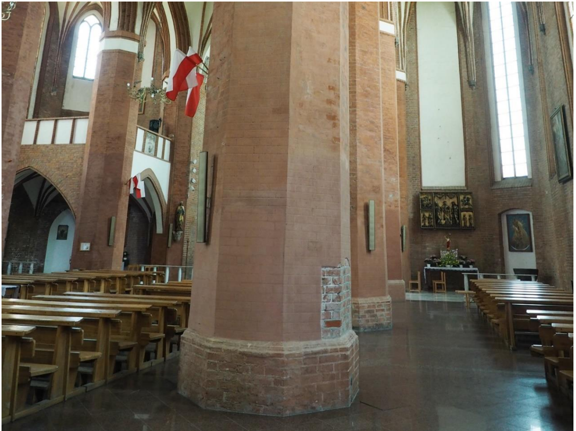
37. Bazylika Mniejsza pw. Św. Katarzyny Aleksandryjskiej w Braniewie, wewnątrz, strona południowa, czwarty filar od zachodu. Widoczny stan cokołu; wtórna warstwa barwna na licach filaru.
