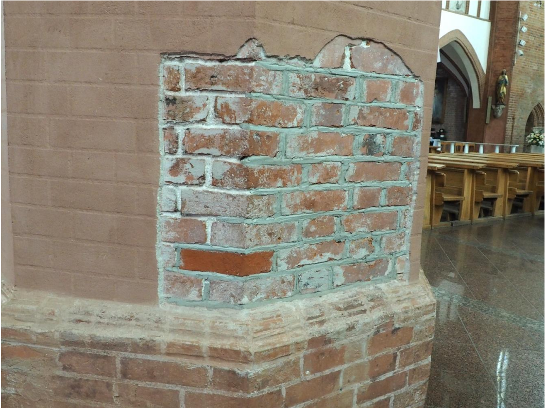
38. Bazylika Mniejsza pw. Św. Katarzyny Aleksandryjskiej w Braniewie, wewnątrz, strona południowa, czwarty filar od zachodu. Widoczna odkrywka; nieestetyczne spoinowanie zaprawą cementową; uzupełnienie lica ceglanego.
