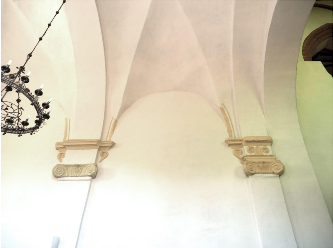
66. Bazylika Mniejsza pw. Św. Katarzyny Aleksandryjskiej w Braniewie, wewnątrz, północna ściana kaplicy południowej. Widoczne pilastry z kapitelami jońskimi wspierające gurty sklepienia.
