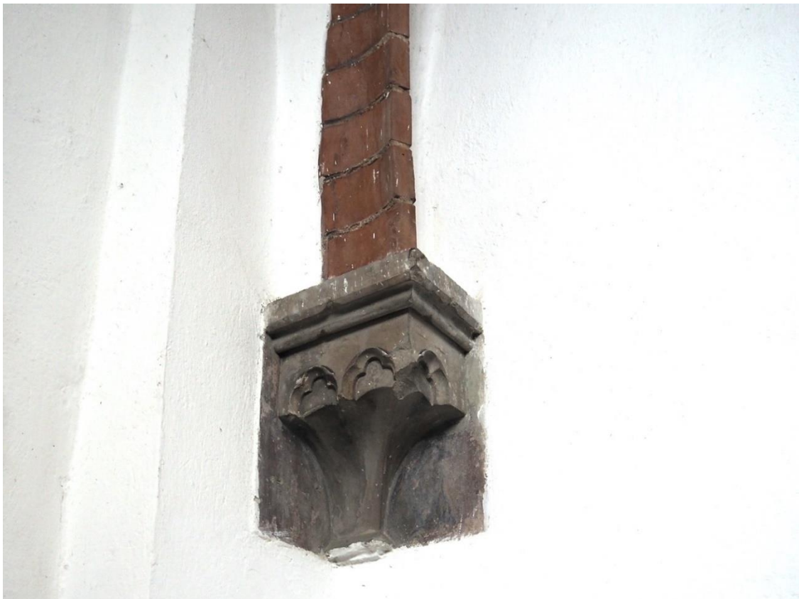
67. Bazylika Mniejsza pw. Św. Katarzyny Aleksandryjskiej w Braniewie, wewnątrz, wschodnia ściana kruchty północnej. Widoczny kapitel maswerkowy.
